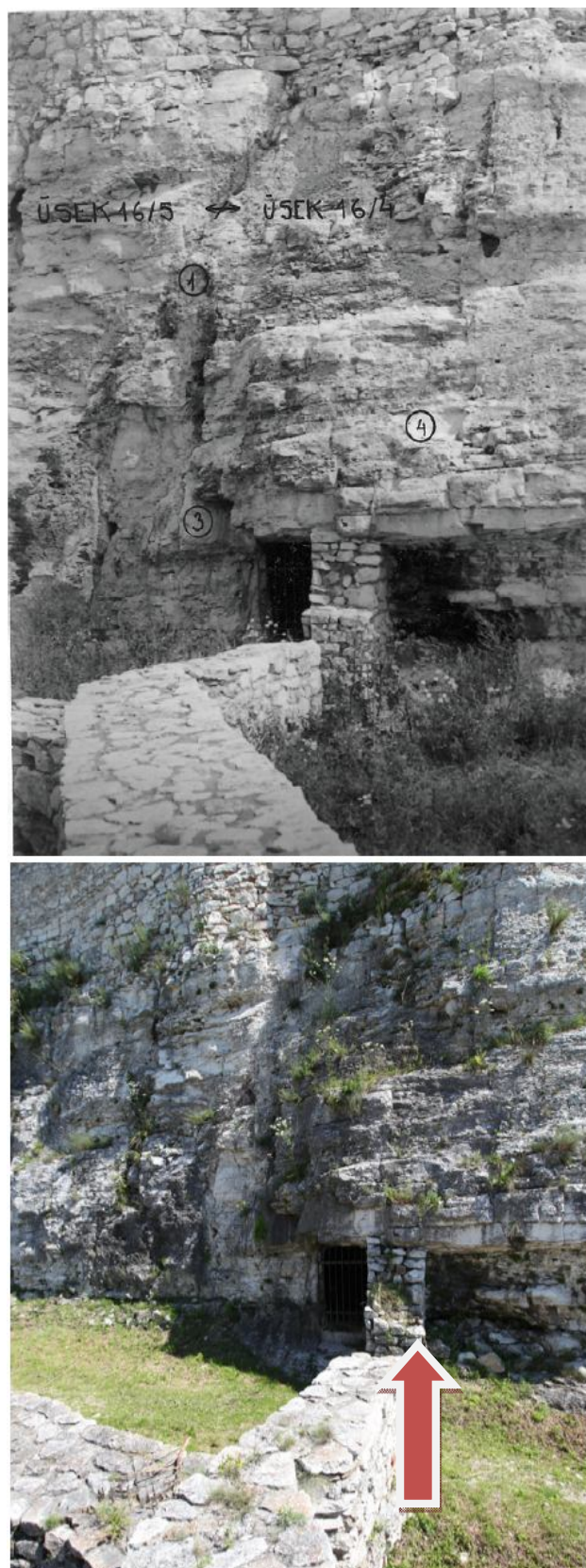
Obr.7 Záver skalnej steny, v dôsledku zvetrania travertínov je na skalnej stene hustý porast náletovej vegetácie, ktorý treba odstrániť, rovnako aj zvetraliny z povrchu skalnej steny. Miesto vyznačené šípkou treba podmurovať.
