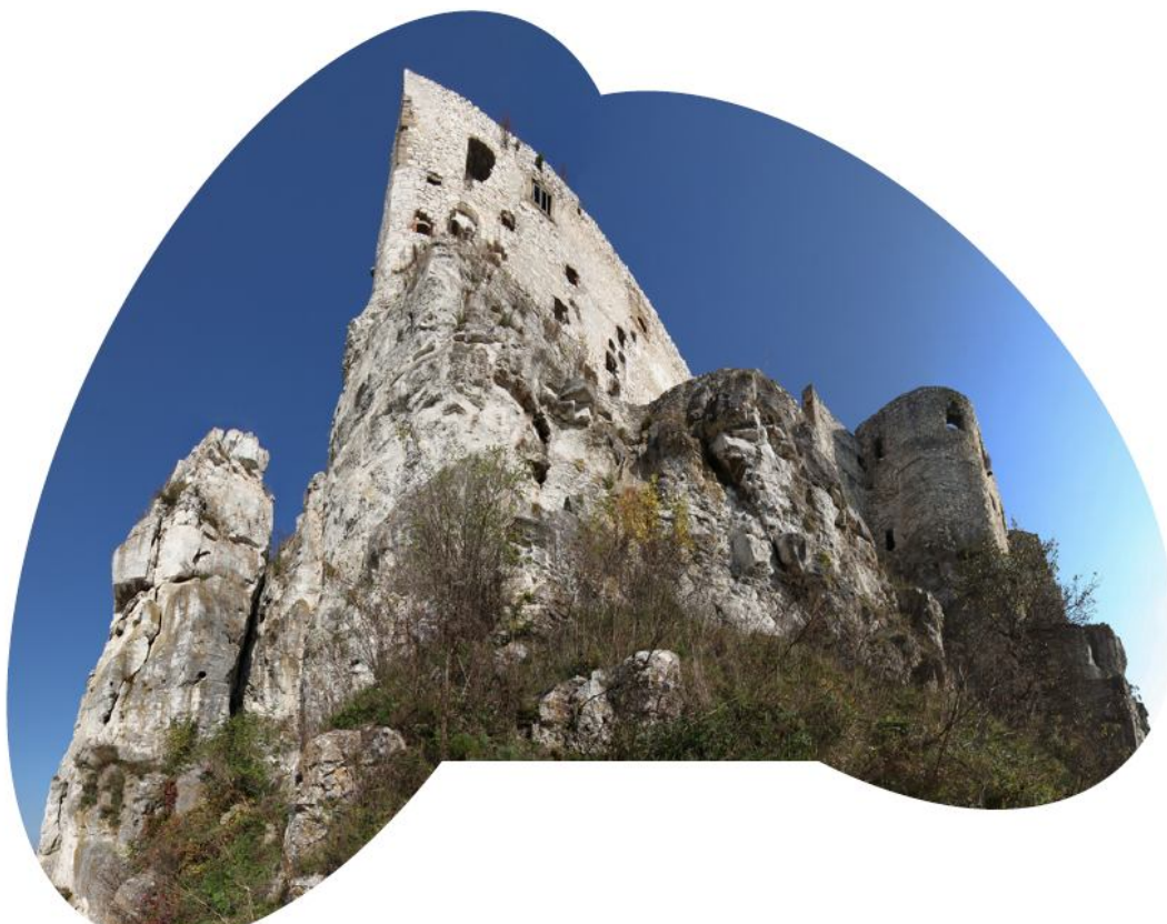
Obr. 1 Vysoké skalné steny dosahujúce miestami výšku až 22 m lemujúce podložie Románskeho paláca Sú súčasťou hradného brala, preto ich odporúčame zachovať v pôvodnom stave. Z hľadiska dlhodobej stability je potrebné ich monitorovať meradlom s kontinuálnym zberom dát.
