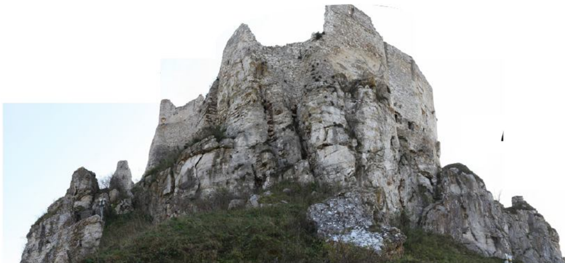
Obr. 2 Vysoké skalné ihly v predpolí Románskeho paláca tvoria morfológickú dominantu hradu. Sú porušené výrazným systémom diskontinuit, i keď nevykazujú v súčasnosti výraznú mobilitu, bude potrebný ich monitoring. Z hľadiska ich stability navrhujeme ponechať v prirodzenom stave
