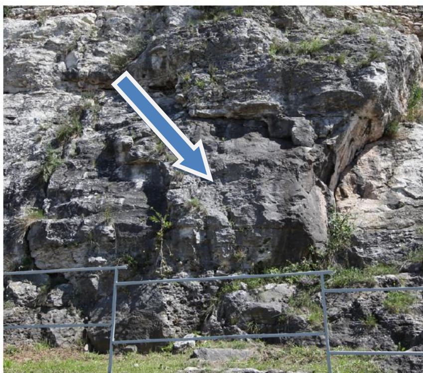
Obr.5 Detail skalného brala z obr. 4. Skalný previs po planárnej šmykovej ploche, bude potrebné sanovať krátkymi kotvami dĺžky 5 m, príp. v niektorých častiach kombinovať s podmurovaním
