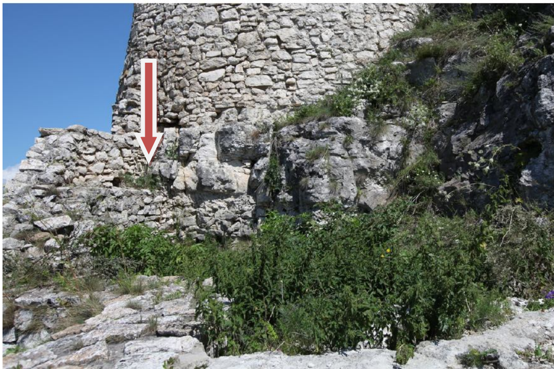
Obr. 9 Nedostatočné naviazanie základového muriva na skalné bloky v jeho podloží. Dokumentuje to zvýšenú kavernóznosť v murive (označené šípkou). Uvoľnené bloky treba spevniť vápennou maltou, doplniť chýbajúce bloky a v časti skalnej steny, kde je previs treba vykonať podmurovanie túto sanáciu
