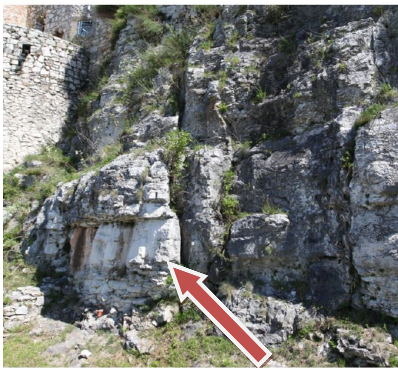
Obr.8 V popredí, šípkou označený uvoľnený skalný blok v dôsledku porušenia typu „wedge failure“, klinovitého porušenia pozdĺž dvoch do masívu zabiehajúcich diskontinuit. Uvoľnený blok nepredstavuje zníženie stability skalnej steny a odporúčame ho ponechať v súčasnom stave. Ako možné sanačné opatrenie prichádza do úvahy nedeštruktívna fixácia krátkymi klincami a vyplnenie ťahovej rozsadliny travertínovými blokmi do vápennocementovej zálievky.
